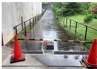
③当館敷地内にも一時、立ち入り制限の表示を設置しました。
